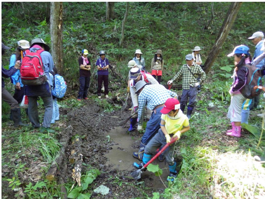
ニッポンザリガニの沢土砂流失止め工事補修
