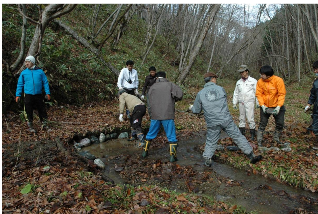
林原の沢土砂流失防止止め石組み市民工事
